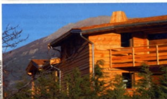
Résidence les Jardins de lumière à Baratier, réalisée par Ocre : structure en béton, habillage de mélèze avec les bardeaux et le bardage, isolation en laine de bois...
